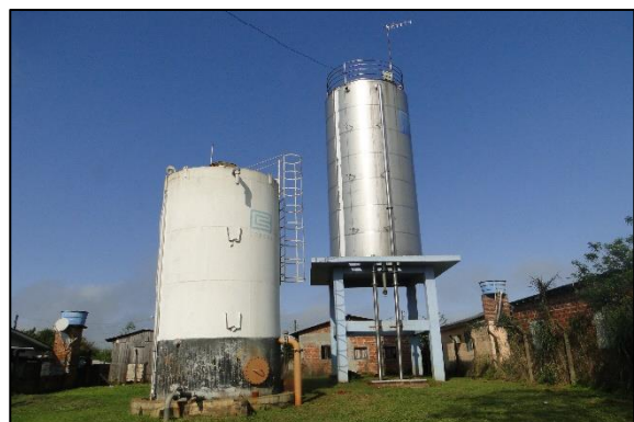
Figura 7-4. Reservatório de água da CORSAN.
