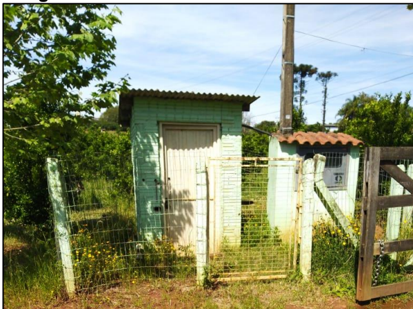
Figura 9-56. Casa de bomba SAC Arroio 2.
