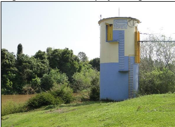
Figura 9-17. Ponto de captação de água bruta
