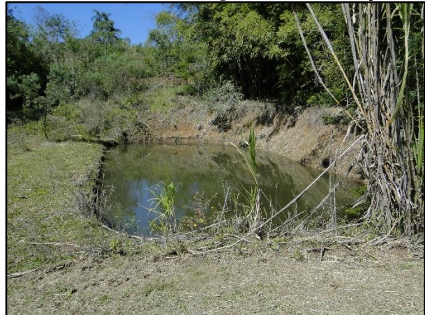
Figura 12-30. Sistema de tratamento de lixiviado, através de lagos de estabilização.
