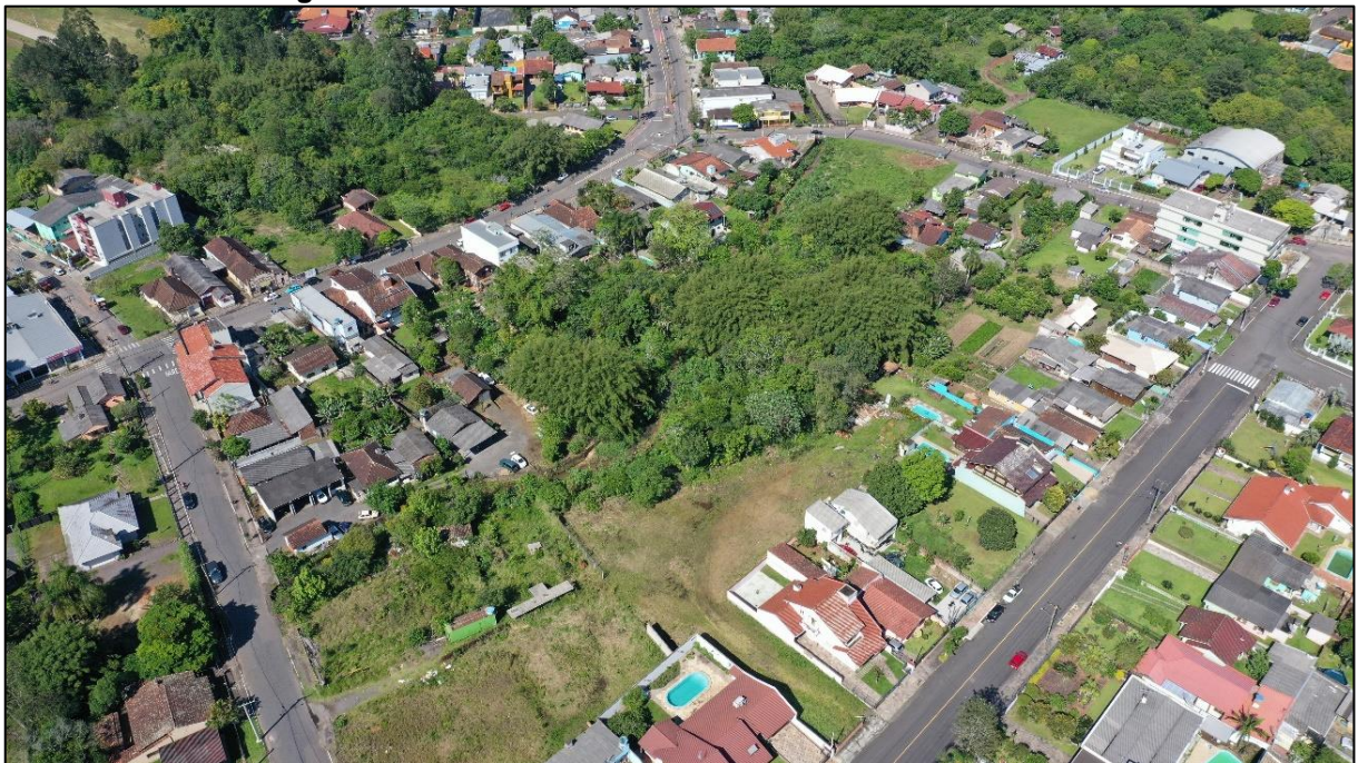
Figura 11-12. Arroio Coitinho atravessando a área urbana.
