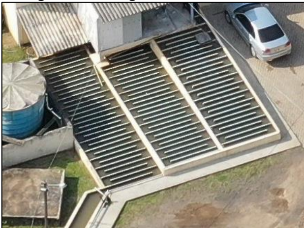
Figura 9-23. Imagem aérea do floculador
