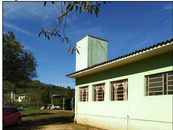
Figura 9-67. Reservatório SAC Santo Inácio.
