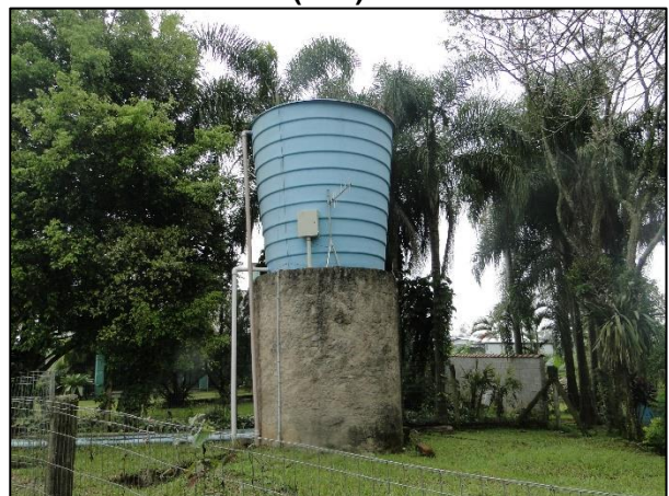
Figura 9-41. Reservatório Hortêncio nº 339 (R09).
