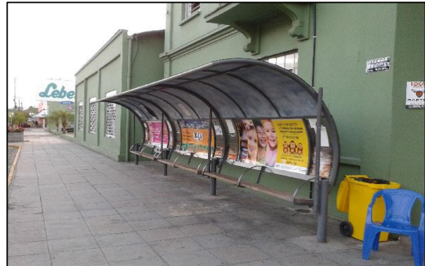
Figura 6-18. Paradas de ônibus na lateral da rodoviária.
