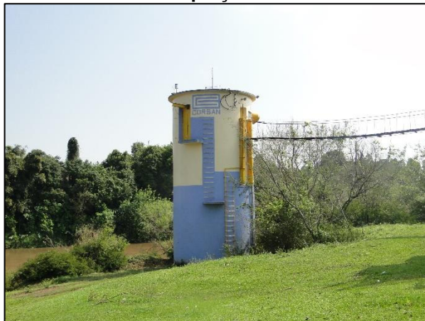
Figura 9-9. Casa de bombas no ponto de captação.
