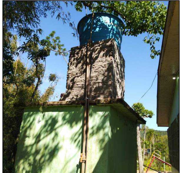
Figura 9-61. Reservatório SAC Centro Integrado Campestre.
