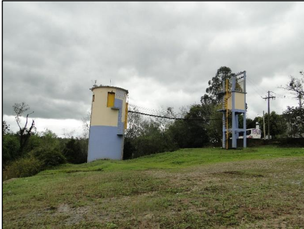
Figura 9-4. Estruturas da CORSAN no ponto de captação.
