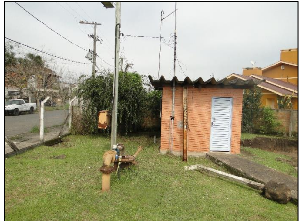
Figura 9-43. Booster Vila Rica ao lado do novo reservatório.
