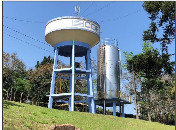
Figura 9-37. Reservatórios ETA-R25 e ETA-R2 (R06 e R07) respectivamente.
