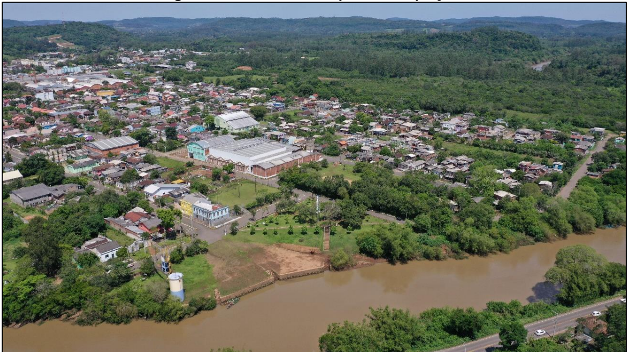
Figura 9-13. Vista aérea do ponto de captação.
