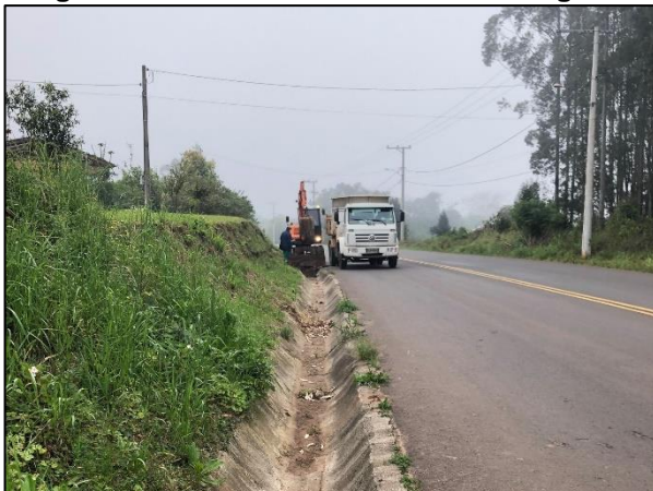
Figura 11-5. Elementos da microdrenagem.
