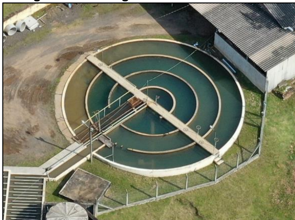
Figura 9-25. Imagem aérea do decantador
