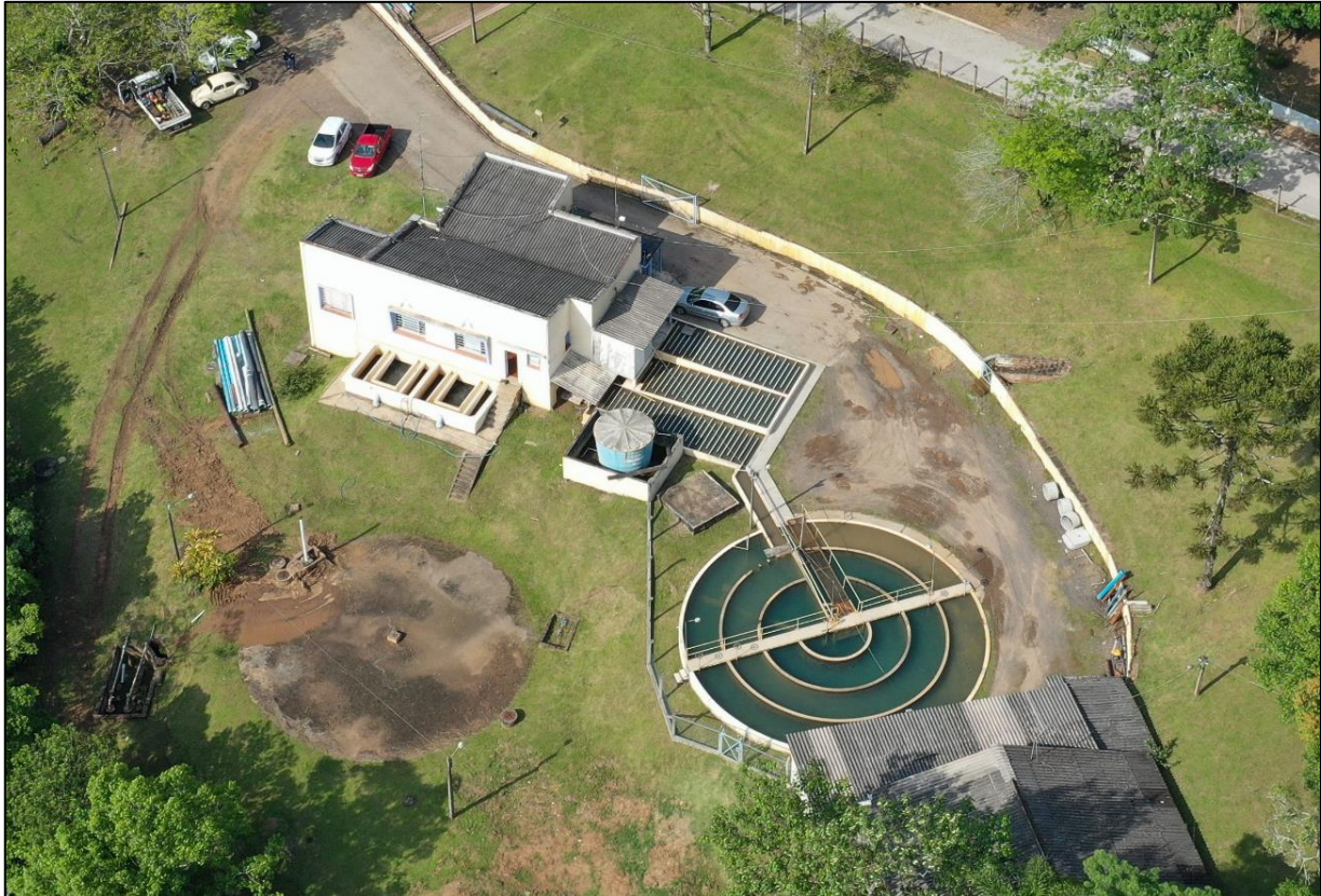
Figura 9-16. Imagem aérea da Estação de Tratamento de Água
