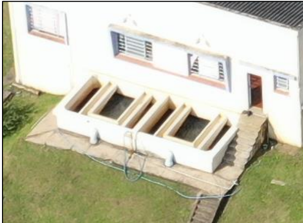
Figura 9-27. Imagem aérea dos filtros rápidos
