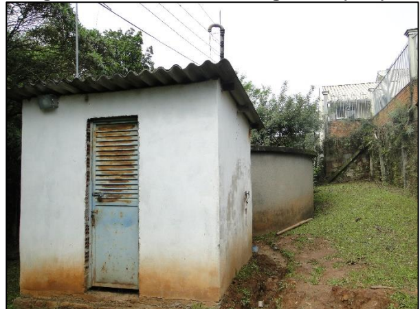
Figura 9-39. Reservatório Argentina (R08).
