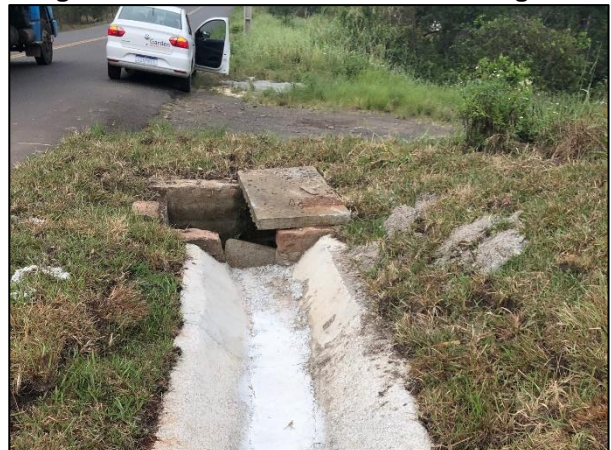
Figura 11-6. Elementos da microdrenagem.
