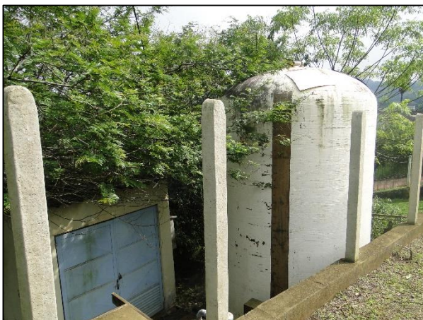
Figura 9-40. Reservatório Hortêncio nº 5 (R10).
