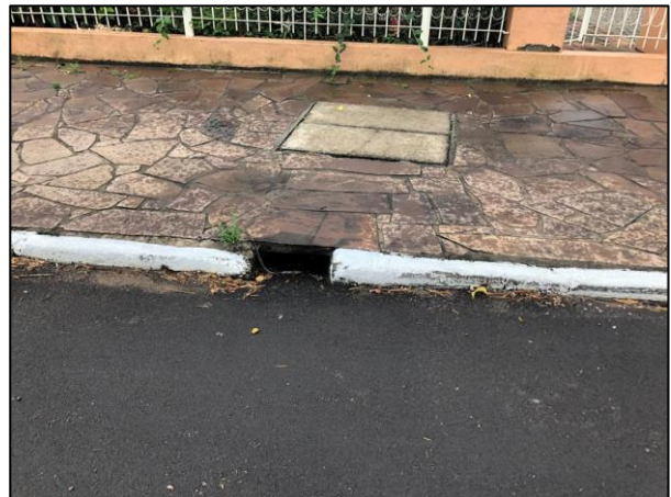
Figura 11-4. Elementos da microdrenagem urbana.
