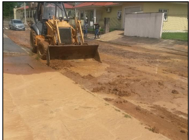
Figura 11-44. Limpeza das ruas após a enchente de outubro de 2015.
