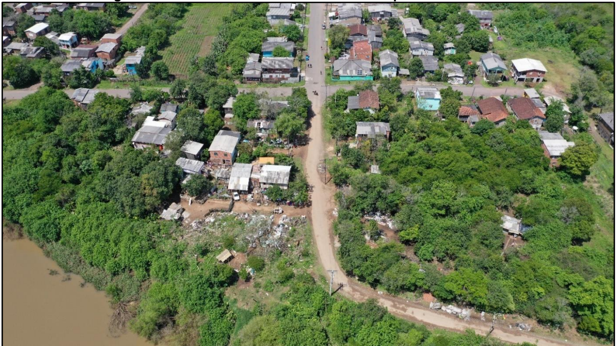
Figura 12-33. Vista da área identificada como passivo ambiental.
