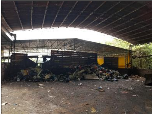
Figura 12-10. Local de depósito dos resíduos recicláveis.
