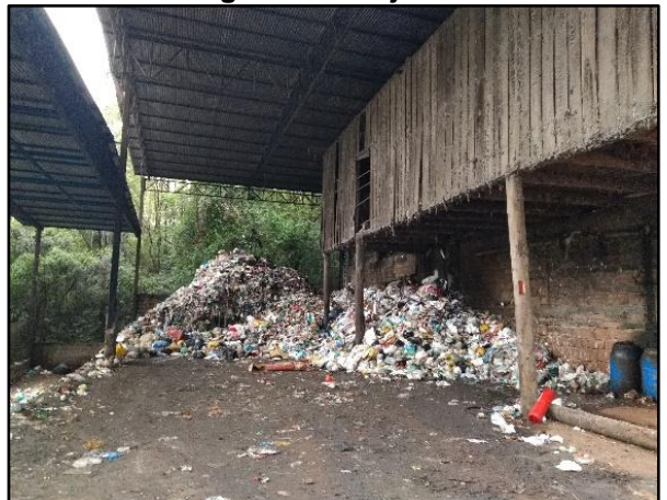
Figura 12-13. Acúmulo dos materiais orgânicos e rejeitos.
