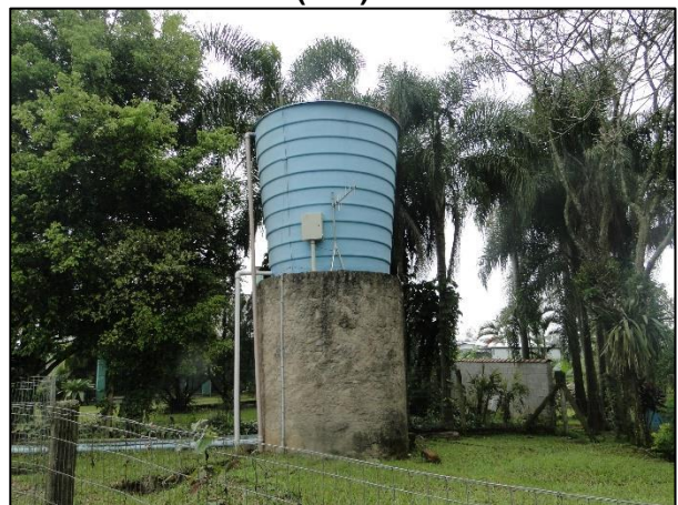
Figura 9-41. Reservatório Hortêncio nº 339 (R09).
