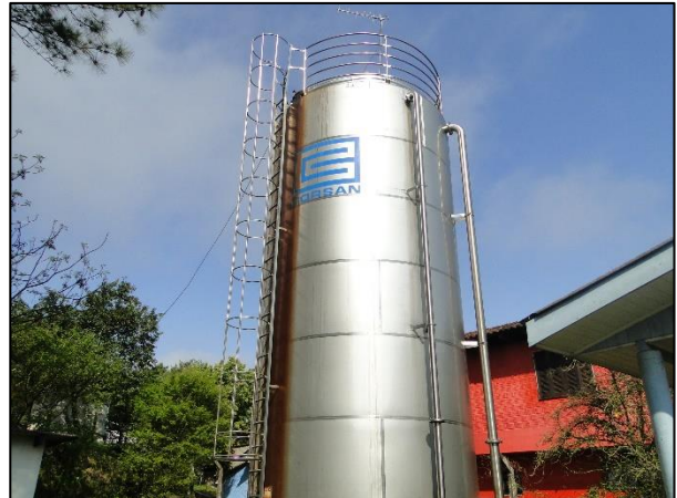
Figura 9-45. Detalhe do reservatório metálico Nelson Hoof nº 853 (R01).
