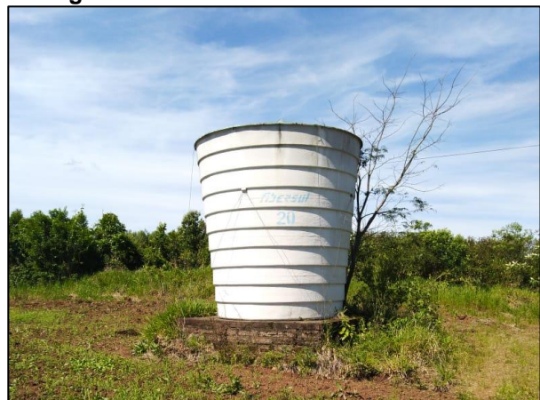
Figura 9-57. Reservatório SAC Arroio 2.
