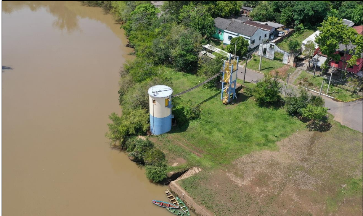
Figura 9-14. Vista aérea do ponto de captação.
