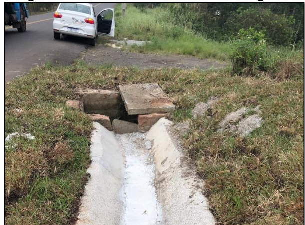
Figura 11-6. Elementos da microdrenagem.
