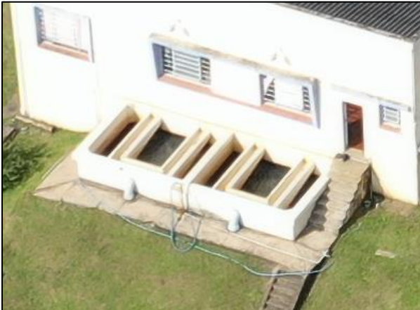
Figura 9-27. Imagem aérea dos filtros rápidos
