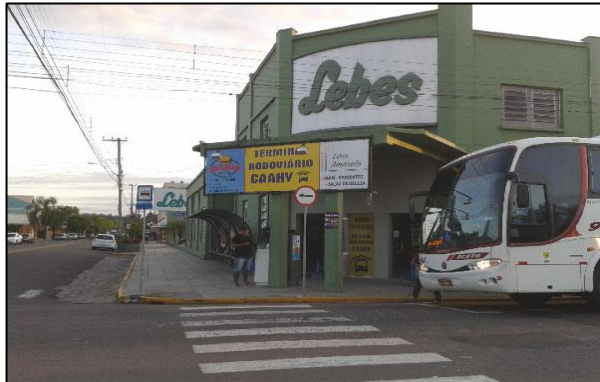
Figura 6-17. Fachada da Rodoviária de São Sebastião do Caí.
