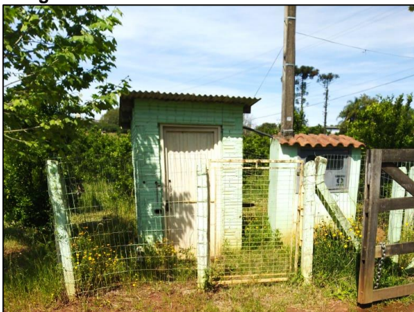
Figura 9-56. Casa de bomba SAC Arroio 2.
