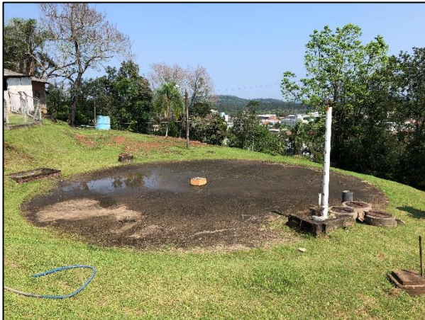
Figura 9-36. Reservatório ETA-R1 (R0).
