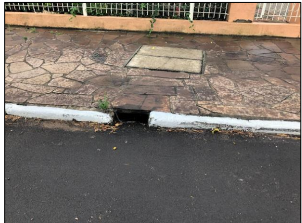
Figura 11-4. Elementos da microdrenagem urbana.
