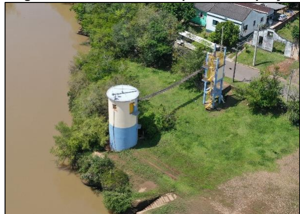
Figura 9-18. Vista aérea do ponto de captação
