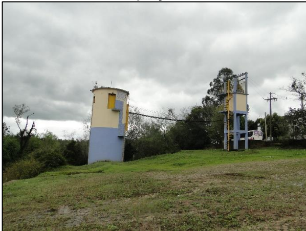
Figura 9-4. Estruturas da Corsan no ponto de captação.
