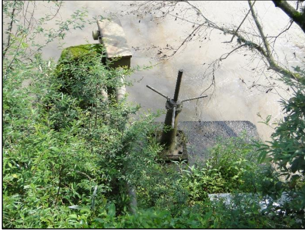
Figura 9-11. Entrada da caixa de captação.
