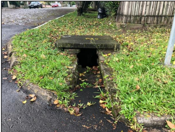
Figura 11-1. Elementos da microdrenagem urbana.
