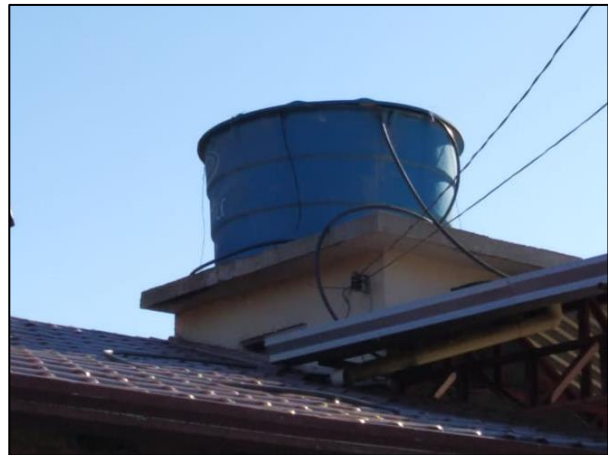
Figura 9-65. Reservatório SAC Praça Timóteo.
