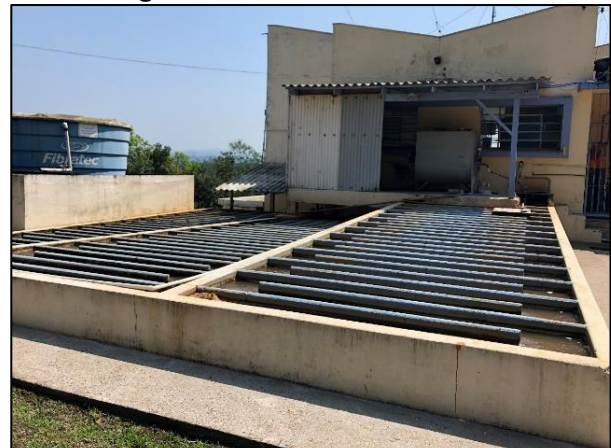
Figura 9-24. Vista do floculador
