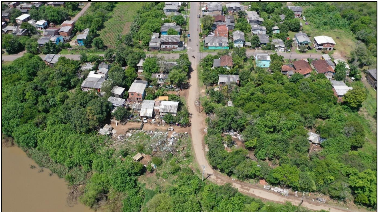
Figura 12-33. Vista da área identificada como passivo ambiental.
