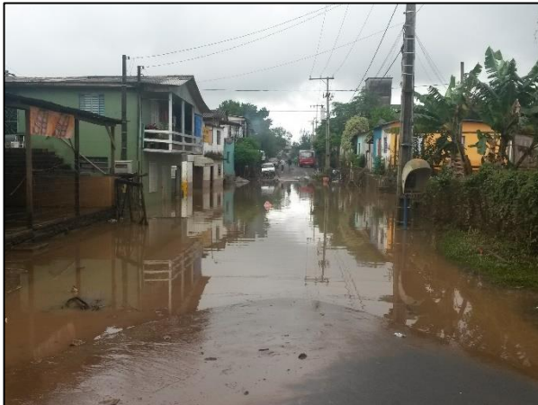
Figura 11-25. Alagamento das ruas na enchente de outubro de 2015.
