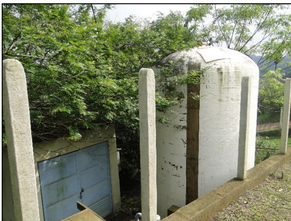
Figura 9-40. Reservatório Hortêncio nº 5 (R10).
