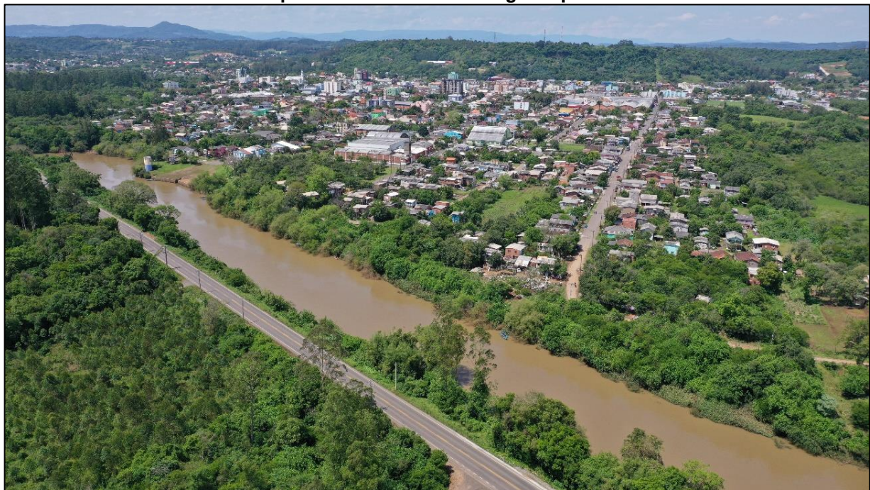
Figura 9-7. Trecho a jusante da captação visualizando a ocupação irregular na margem esquerda e a RS-124 na margem oposta.
