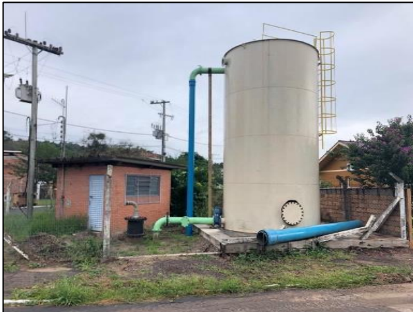
Figura 9-42. Reservatório Vila Rica (R12).
