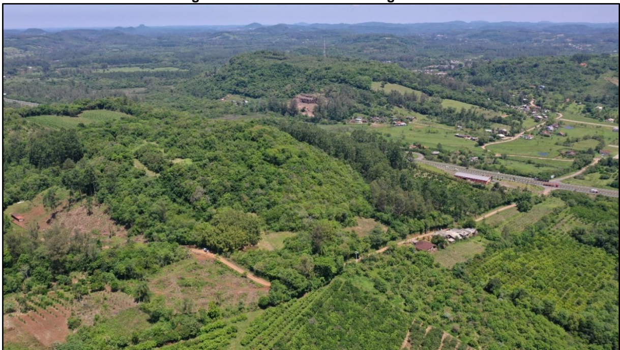
Figura 12-22. Vista aérea do antigo lixão.
