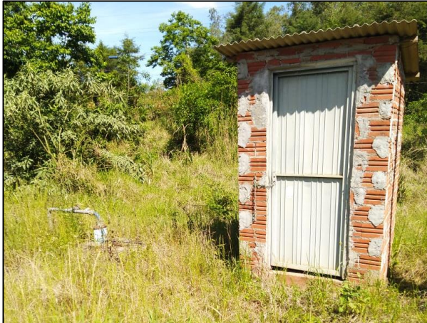
Figura 9-58. Casa de bomba SAC Santa Teresinha.
