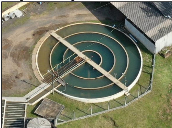
Figura 9-25. Imagem aérea do decantador
