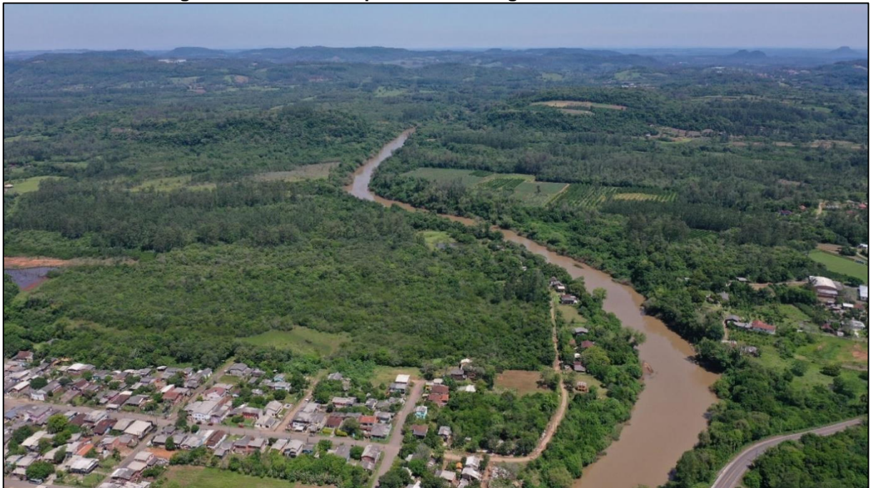
Figura 11-17. Vista do ponto de estrangulamento do Rio Caí.
