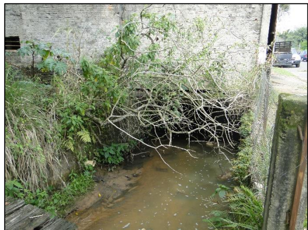
Figura 10-10. Registro do ponto 02 no Arroio Coitinho.
