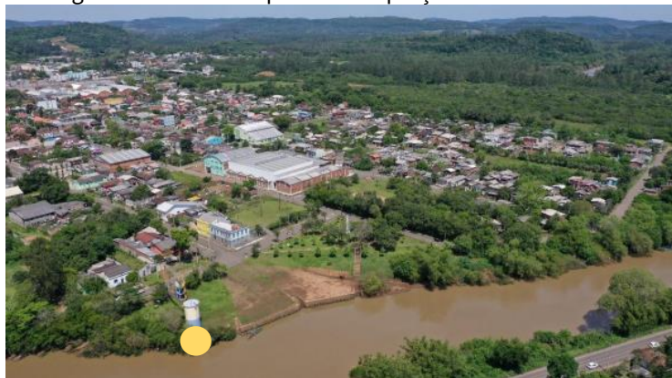
Figura 121 – Vista do ponto de captação do SAA no rio Caí
