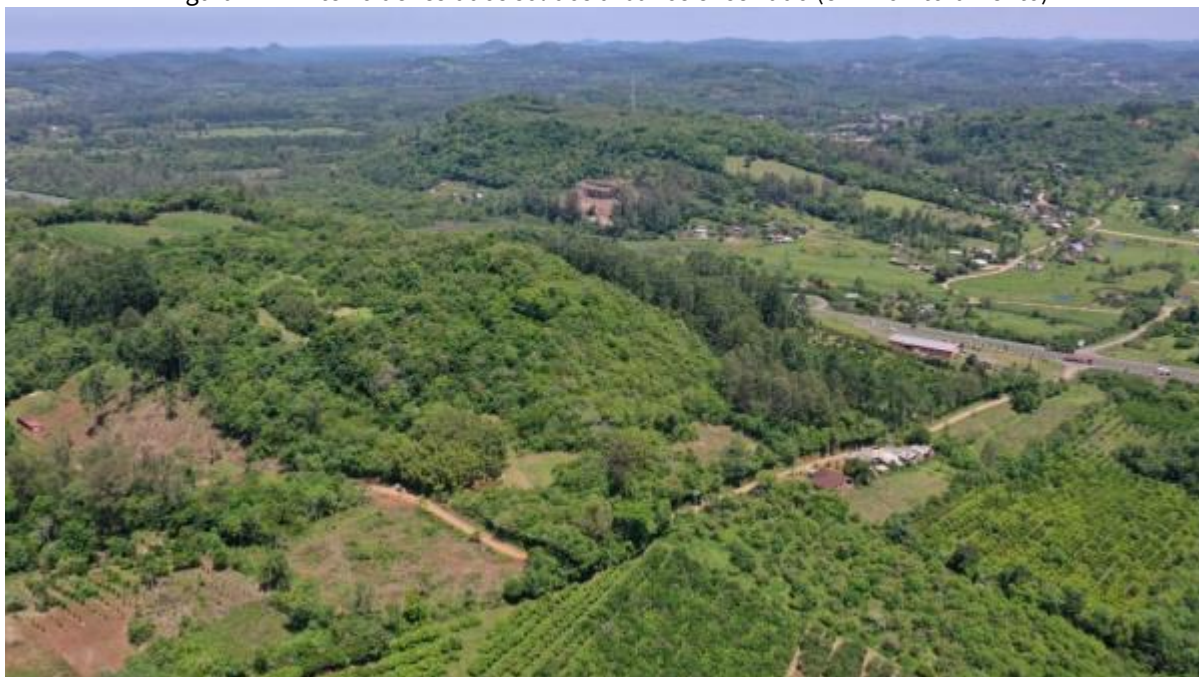
Figura 122 – Aterro de resíduos sólidos urbanos encerrado (em monitoramento)
